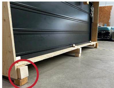
Vor dem Öffnen der Kiste, muss diese an der Vorderseite unterbaut werden. Die Kiste muss mit einer Neigung von ca. 5° nach hinten geneigt stehen. Dies verhindert das Herausfallen der Fenster beim Lösen der Transportsicherung.
