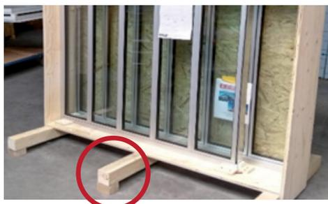
Antes de abrir la caja, ésta se deberá suplementar en la parte delantera. La caja deberá quedar inclinada ligeramente hacia atrás. Esto evitará que las ventanas se caigan cuando se afloje el seguro de transporte.
