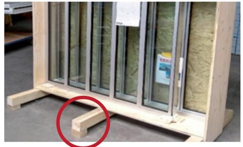
Vor dem Öffnen der Kiste, muss diese an der Vorderseite unterbaut werden. Die Kiste muss leicht schräg nach hinten geneigt stehen. Dies verhindert das Herausfallen der Fenster beim Lösen der Transportsicherung.
