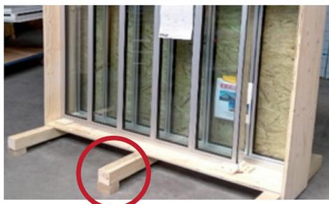
Antes de abrir a caixa, ela deve ser estabilizada por uma subestrutura na parte da frente. Para isso, a caixa tem de ser inclinada para trás, formando um pequeno ângulo. Isso evita que as janelas caiam quando sejam removidos os elementos de segurança para o transporte.
